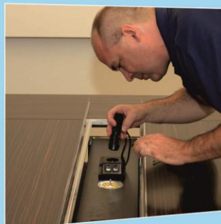
Kontrola elektroinstalací, zásuvek, vypínačů.
